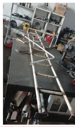
Escada marinheiro em construção
