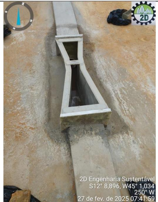
**Observações:** instalação de calha parshall para medição de vazão de saída.
