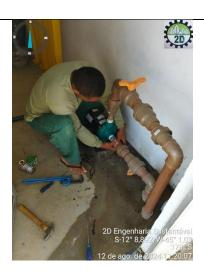
Observações: solução de vazamento de bomba.
