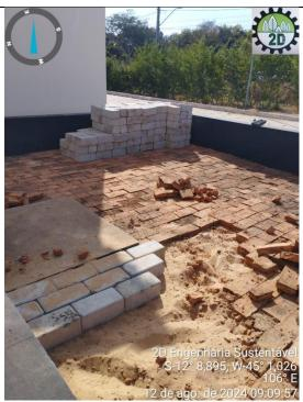
Observações: troca de camada filtrante de leitos de secagem.
