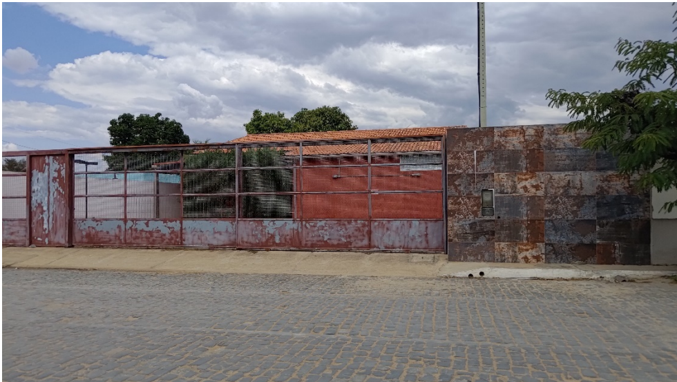
Figura 127 - Fachada da Casa do Juiz de Santa Maria da Vitória.
