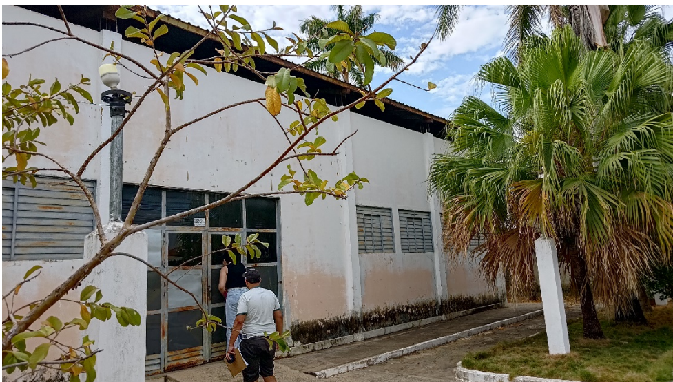
Figura 131 - Vista do acesso do Centro de Múltiplo Uso.
