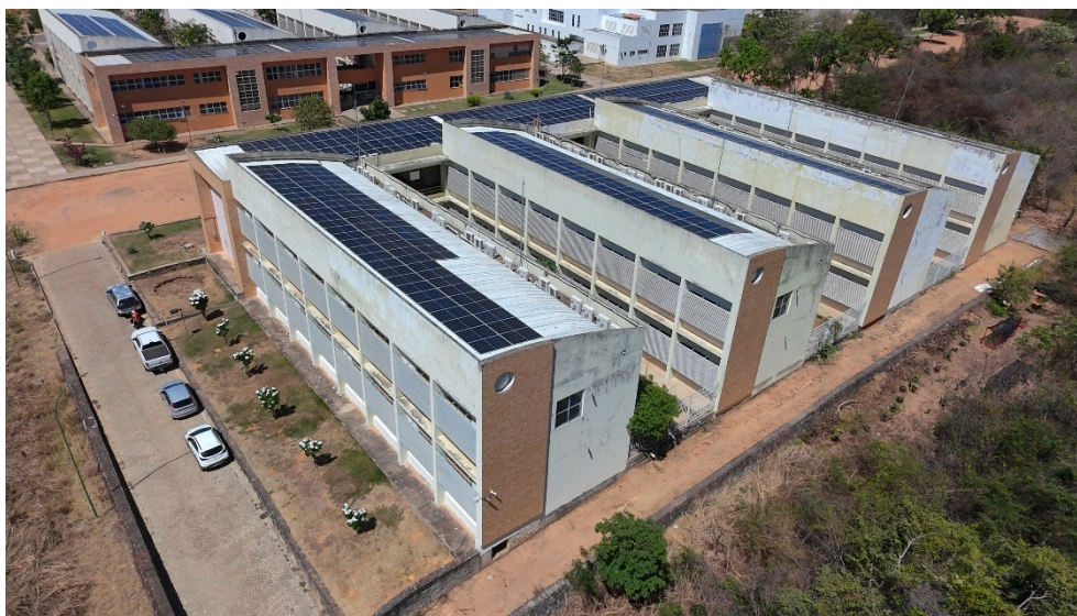
Figura 56 - Pavilhão de aulas um - PD do CRES.
