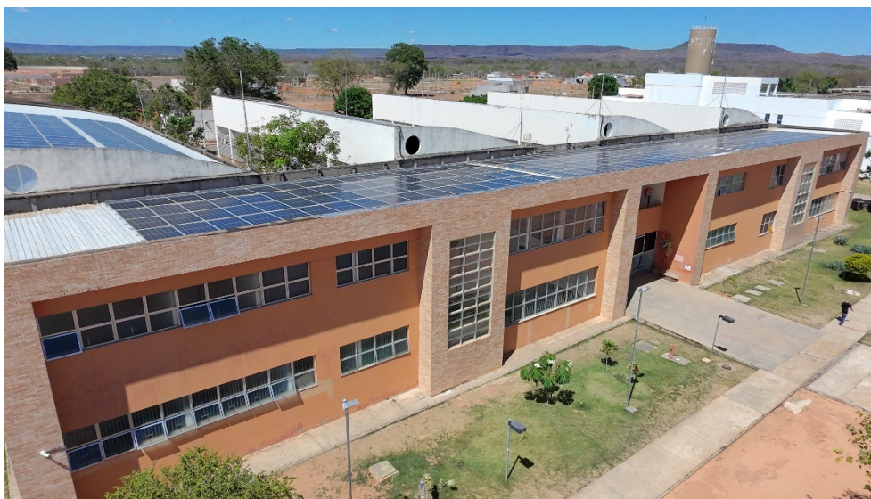
Figura 58 - Pavilhão de aulas dois - PD do CRES.
