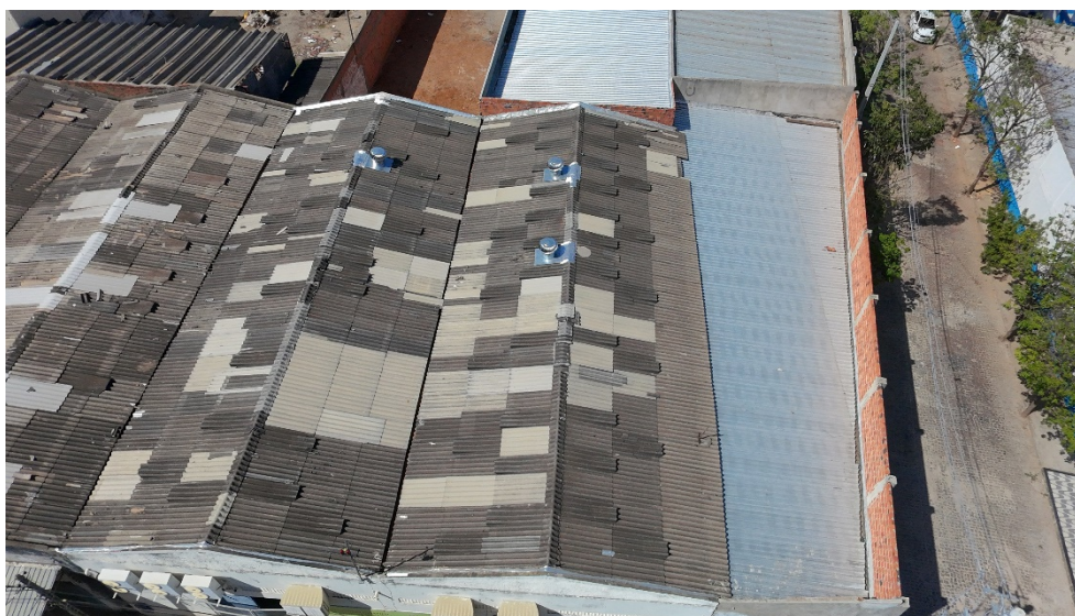
Figura 97 - Foto da cobertura do Galpão de Engenharia Mecânica de Bom Jesus da Lapa. Outubro 2025.
