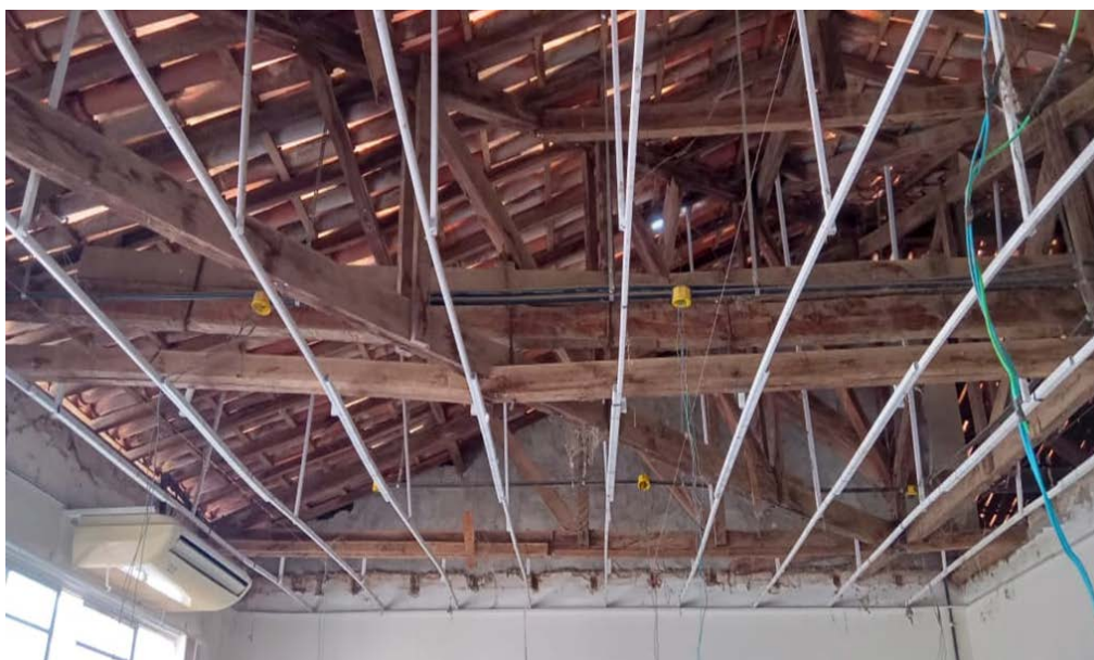
Figura 92 - Ilustração da parte da estrutura danificada no Centro Multidisciplinar de Bom Jesus da Lapa, motivo da interdição de uma sala de aula.
