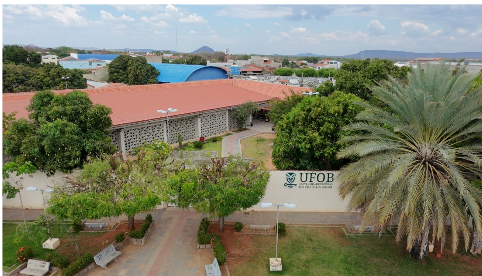
Figura 122 - Vista do acesso ao Centro Multidisciplinar de Santa Maria da Vitória.
