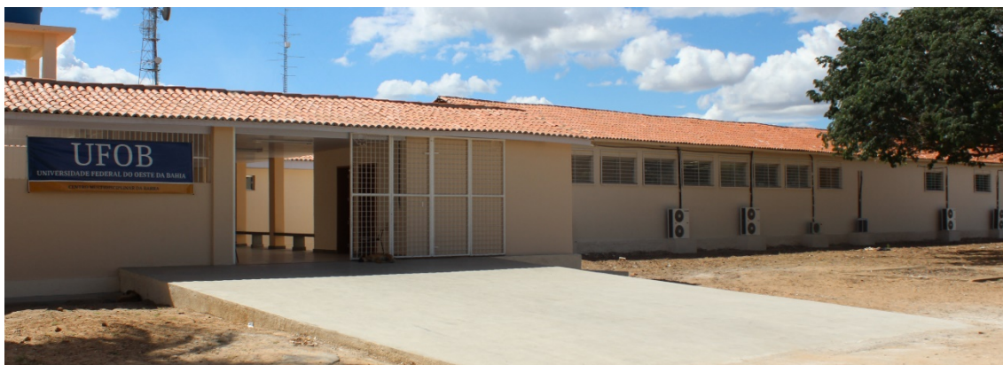
Figura 17 - Fachada interna do Centro Multidisciplinar da Barra
