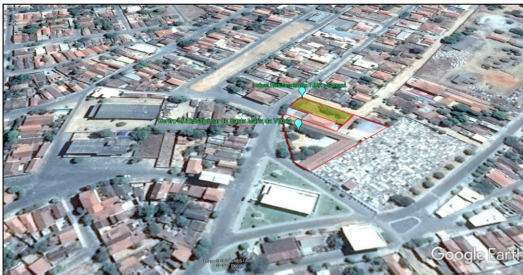
Figura 2. Imagem aérea e cadastro da sede do Centro Multidisciplinar de Santa Maria da Vitória.
