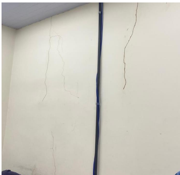
Figure 4 - Cupins nas paredes das salas do prédio do Campus Barra, constatado durante visita in-loco.
