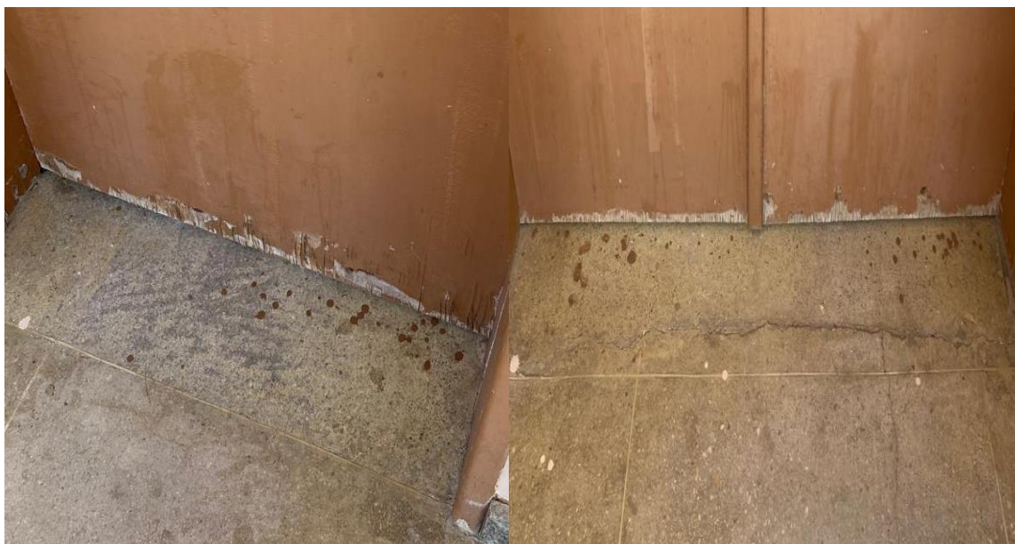
Figure 6 -Deterioração nas portas do Campus Barra, constatada durante visita in loco
