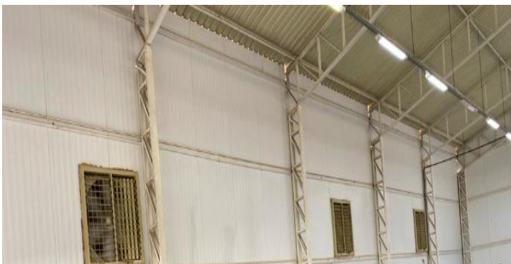
Figura 5 - Sistema de Ventilação do RUP
