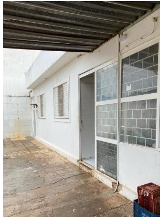
Figura 4 - Porta de acesso a área externa (aberta)
